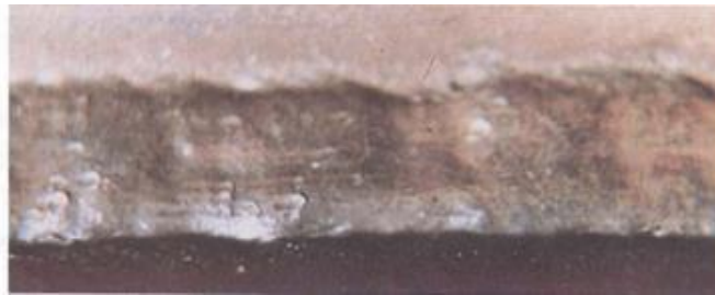
Figura 2- 33: Socavados en una junta de soldadura
