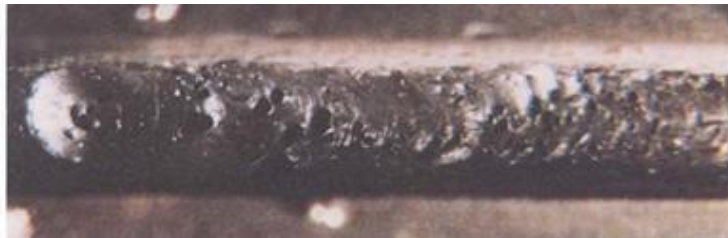
Figura 2- 30: Porosidades en el cordón de soldadura
