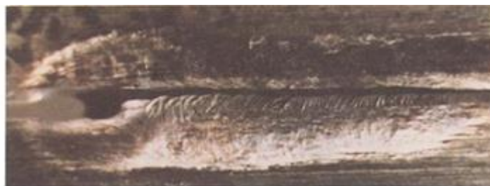
Figura 2- 31: Fusión incompleta en una junta soldada
