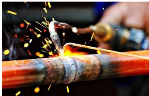
Figura 2- 24: Soldadura fuerte en tubería Fuente: FERREPRO Realizado por: Borja, Darío; 2021.
