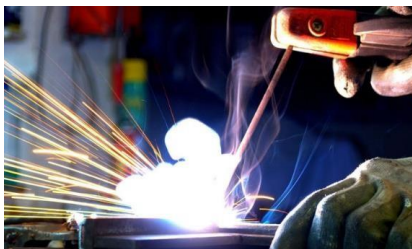
Figura 2- 1: Arco eléctrico en proceso SMAW
