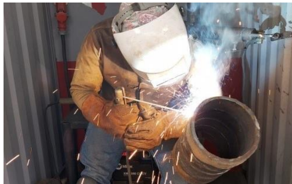
Figura 2- 4: Proceso SMAW en cupón de tubería
