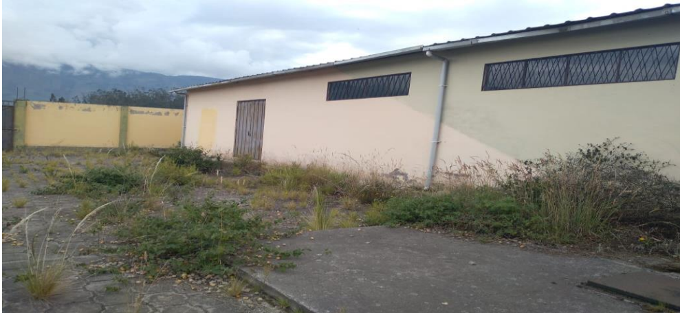
Figura 6-3. Instalaciones civiles de BAYFRUIT Realizado por: BAYFRUIT
