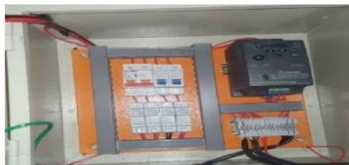
**Figura 5-2.** Tablero de control del módulo soplador ensamblado.
