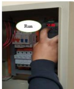
**Figura 2-3.** Puesta en marcha del variador de frecuencia
