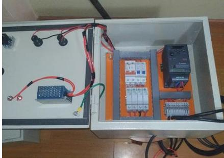
**Figura 9-2.** Cableado de la caja de control para el módulo soplador.
