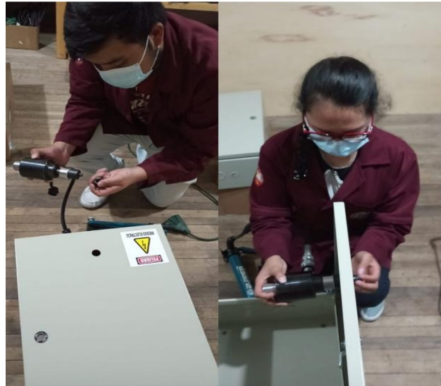
Figura 5-3: Agujeros mediante el uso de un sacabocados hidráulico.
