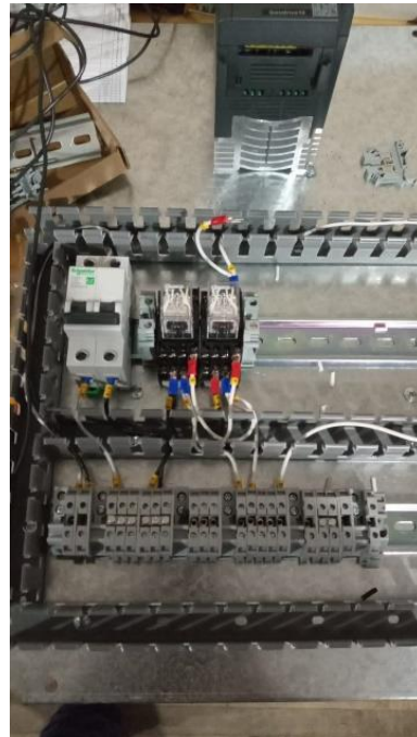
Figura 18-3: Puntos comunes en las conexiones.
