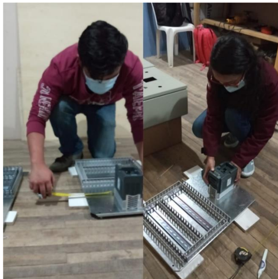
Figura 10-3: Colocación del variador de frecuencia.
