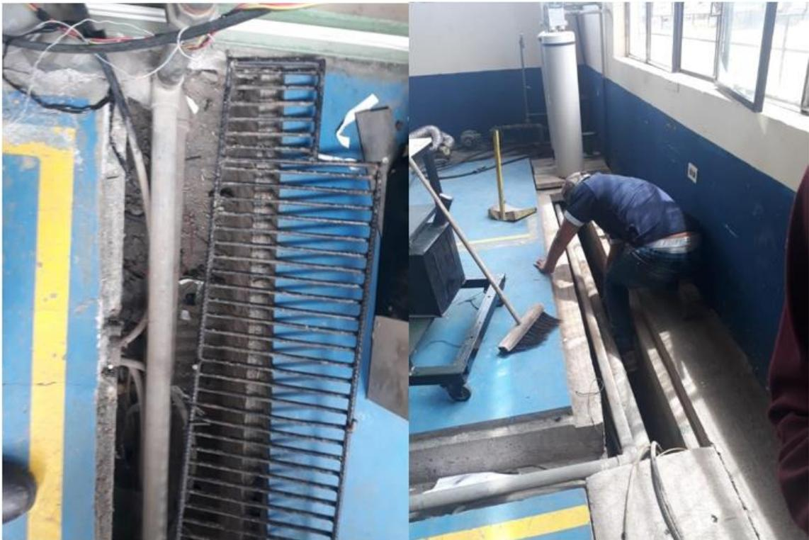
**Figura 20-3:** Limpieza de rejillas y drenajes
