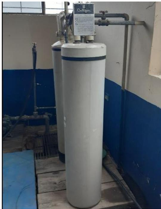
**Figura 10-3:** Tanques suavizadores de agua
