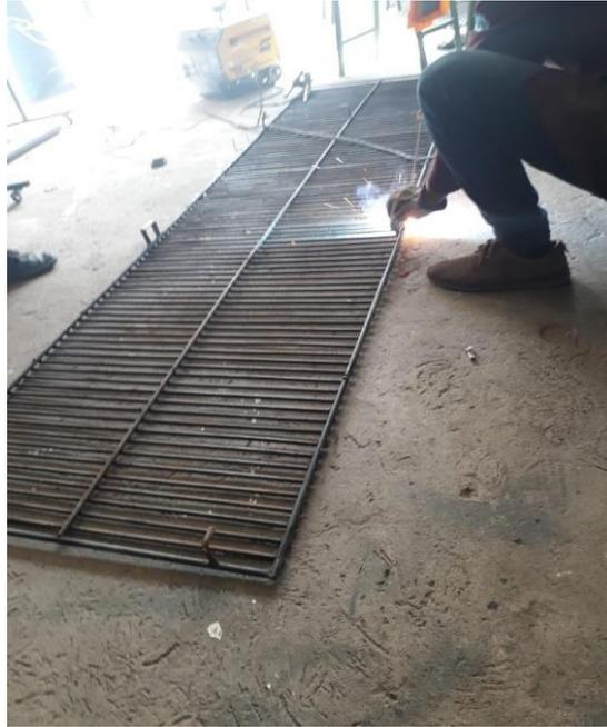
**Figura 21-3:** Soldadura de Rejillas en mal estado
