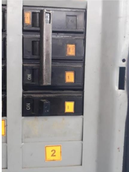
**Figura 9-4:** Braker de encendido de Bomba de agua.
