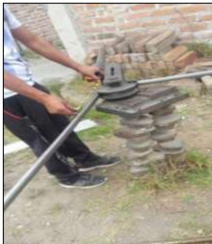
Figura 47-3: Proceso de doblado de tubos
