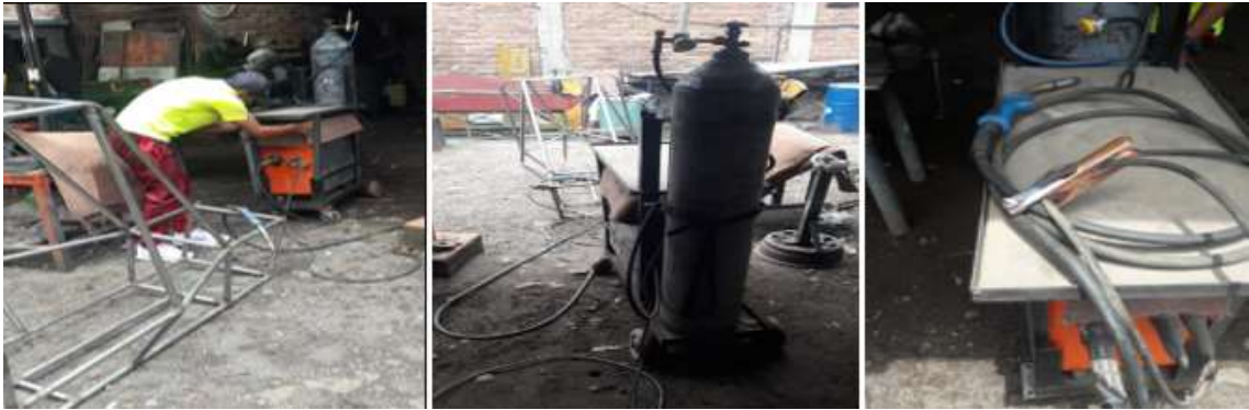
Figura 57-3: Instalación de equipo de soldadura MIG
