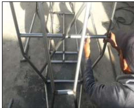
Figura 56-3: Colocación del tubo transversal
