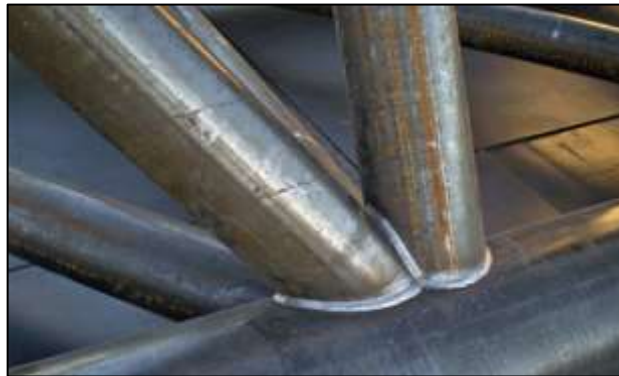
Figura 26-4: Cordón de soldadura final
