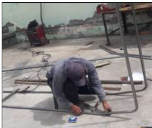
Figura 49-3: Fijación de los parantes principales
