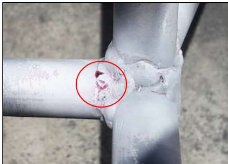
Figura 28-4: Resultados de la inspección de líquidos penetrantes
