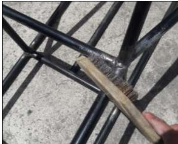
Figura 68-3: Preparación de la superficie de soldadura
