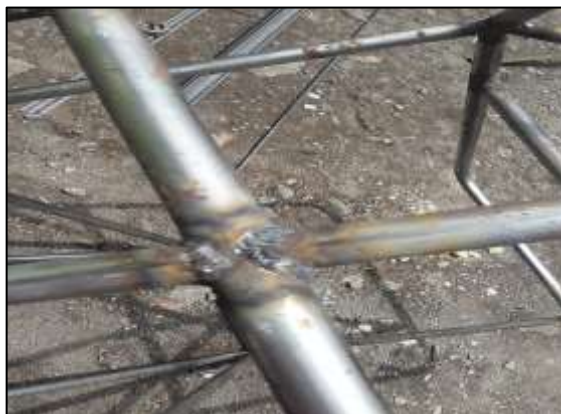
Figura 61-3: Cordón de soldadura, unión entre los tubos de la base del chasis
