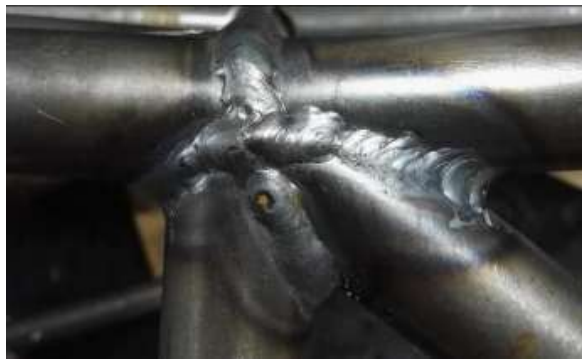
Figura 63-3: Cordón de soldadura
