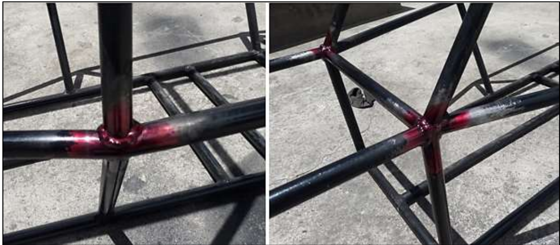
Figura 70-3: Aplicación del líquido penetrante
