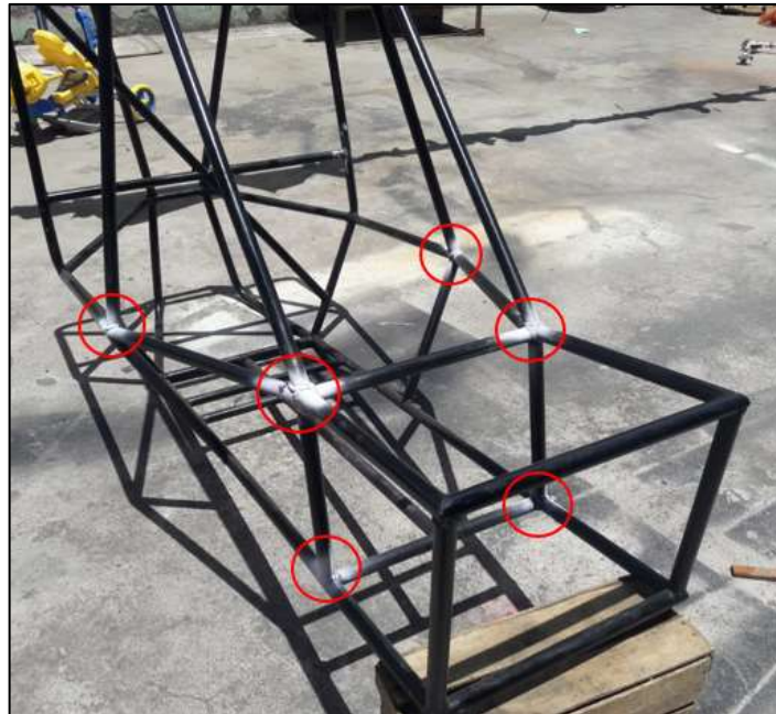
Figura 27-4: Uniones soldadas sujetas a inspección de líquidos penetrantes
