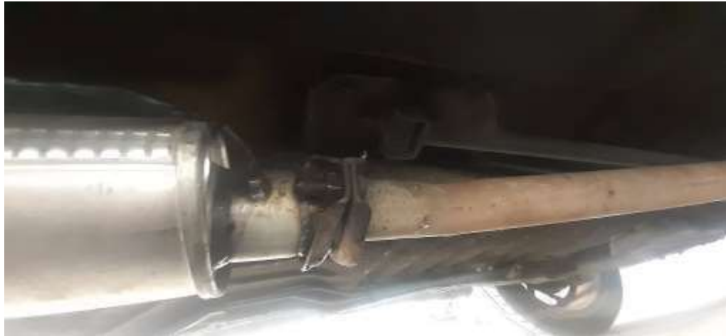
Figura 20-2: Termocupla colocada antes del catalizador.
