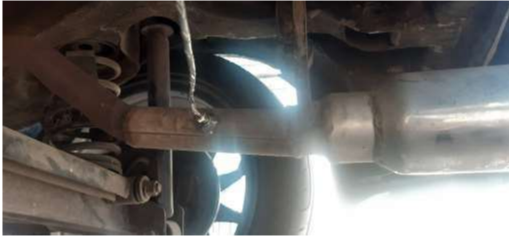
Figura 22-2: Termocupla colocada al final del tubo de escape.
