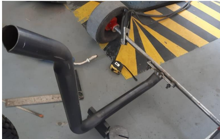
Figura 26. Corte y doblado de tubos
