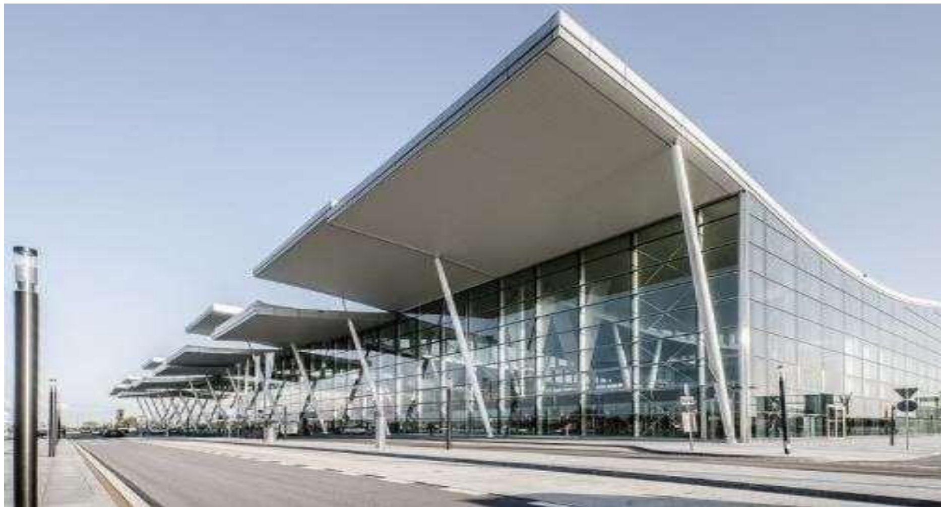
Figura 37-3: Fachada Lateral - Terminal T3 Realizado por: Peñafiel; A & Buñay, V. 2021
