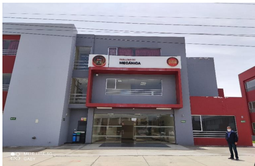
Figura 1-3: Edificio de laboratorios de la facultad de mecánica de la ESPOCH Realizado por: Miranda Gabriela, 2022.
