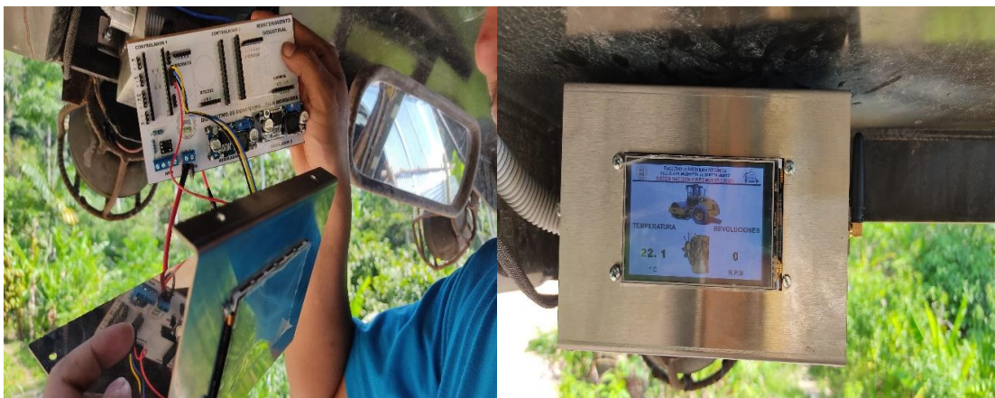
Figura 61-3: Ubicación de la caja contenedora en el habitáculo de la maquinaria
