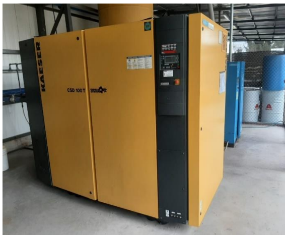
Figura 13-2. Compresor de tornillo rotativo
