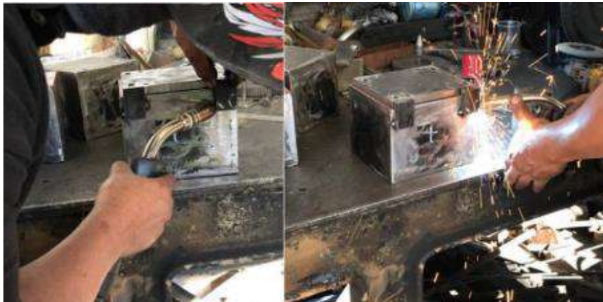
Figura 36-10: Colocación y soldado de los soportes
