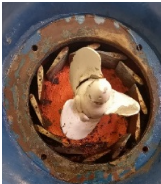
Figura 7-3: Turbina corroída y álabes deteriorados
