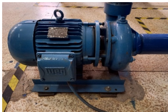
Figura 13-3: Después del mantenimiento
