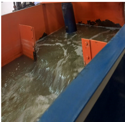
Figura 4-3: Segundo depósito de agua
