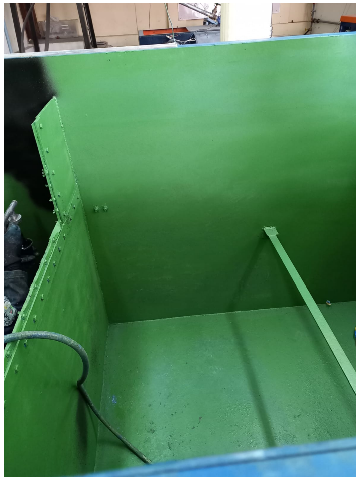
Figura 24-3: Aplicación de pintura de fondo
