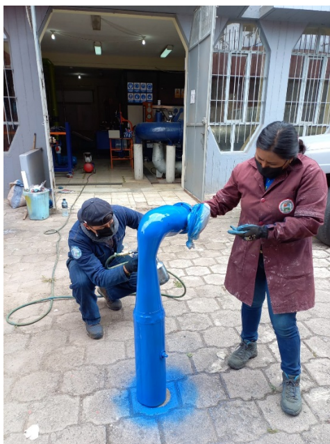
Figura 30-3: Mantenimiento preventivo al tubo de aspiración.
