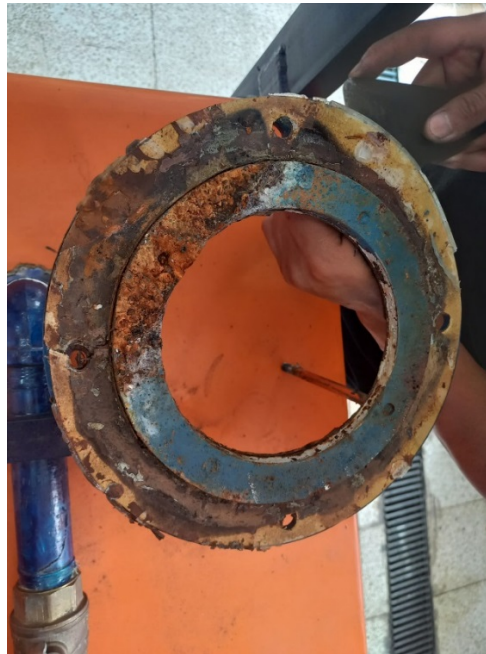
Figura 27-3: Empaque antes del mantenimiento
