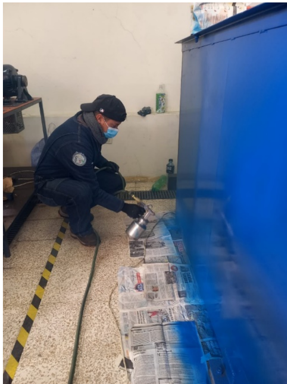
Figura 26-3: Aplicación externa de pintura anticorrosiva 42
