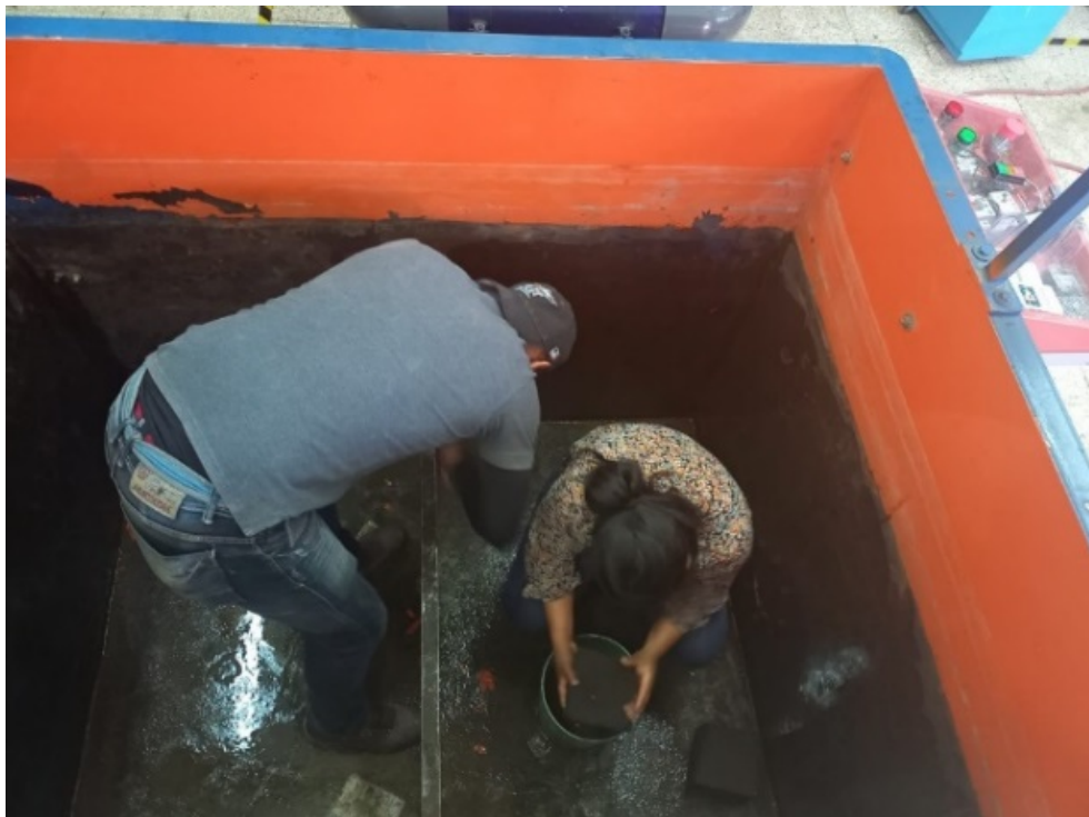
Figura 22-3: Paredes lijadas – limpieza
