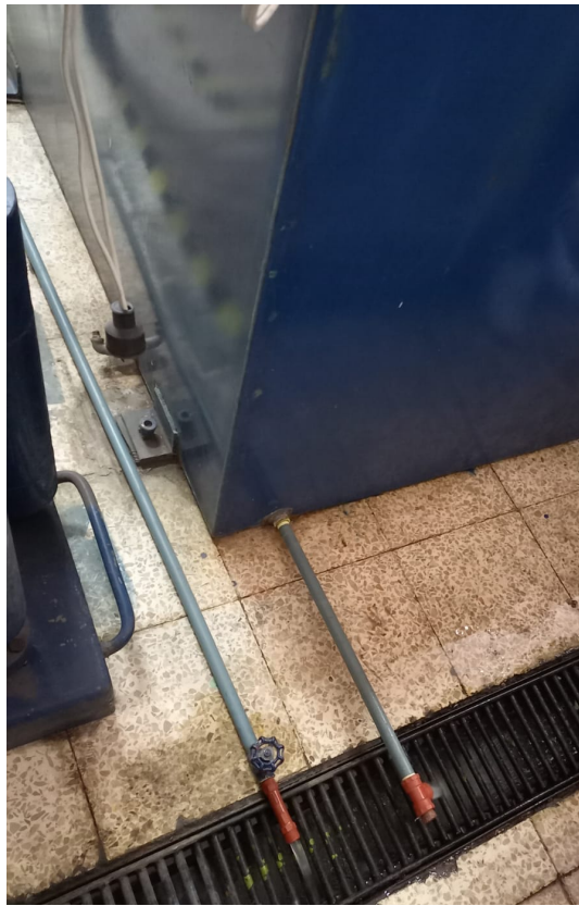
Figura 17-3: Tuberías después del mantenimiento
