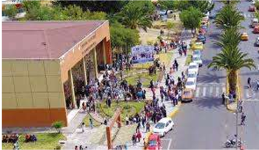
Figura 3-1. Vista panorámica de la universidad
