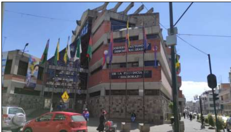
Figura 1-3: Gobierno Autónomo Descentralizado de la Provincia de Chimborazo
