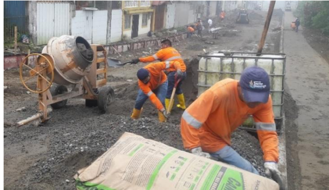
Figura 16-3: Cuadrillas; trabajos en vía pública
