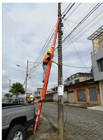
Figura 13-3: Equipos de mantenimiento; trabajos en altura
