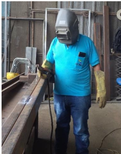
Figura 5-4: Dotación EPP's; Soldadores
