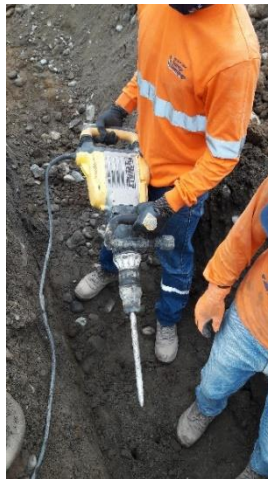
Figura 18-3: Cuadrillas; uso de martillo demoledor
