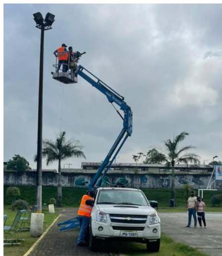
Figura 11-3: Equipos de mantenimiento; trabajos con canastilla
