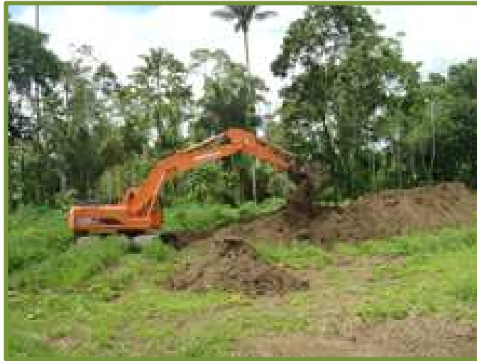
FOTOGRAFÍA No. 4: TRABAJOS DE REMOCIÓN DEL SUELO
