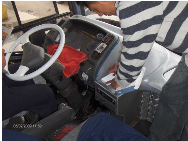
Fig. VI.05. Instalación del MI
