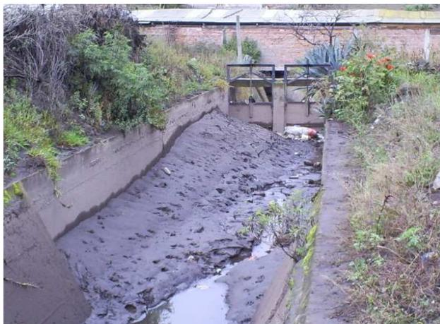
**Foto 2.1-4 Compuerta de entrada al reservorio**
