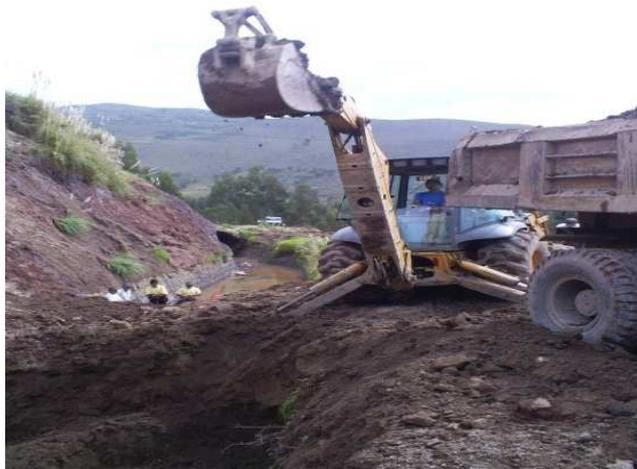
**Foto 2.1-3 Incorporación del material en el canal de conducción**
