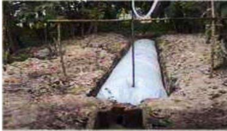
Figura 4 – 2. Biodigestor de tipo tubular
