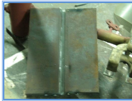
Fig. 4.6, Fase de raíz terminada.
