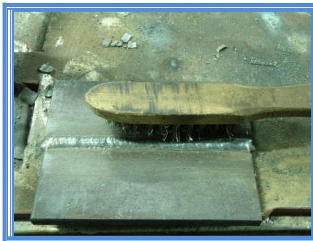
Fig. 4.10, Limpieza del último cordón de soldadura.
