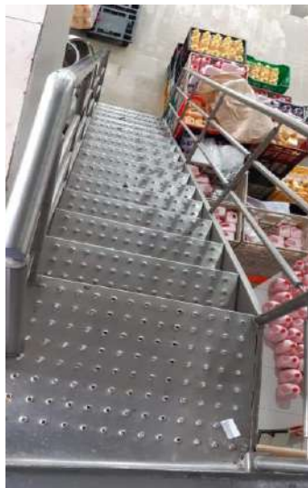
Figura 6-3: Estructura de escaleras y barandas
