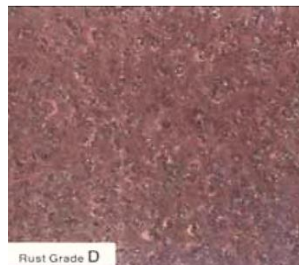
Figura 4-1. Grado de corrosión tipo D.
