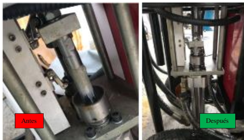
Figura 19-3. Mantenimiento del vástago de los dos cilindros de simple efecto
