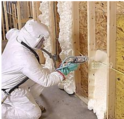
Figura 7-2. Inyección de la espuma de poliuretano
