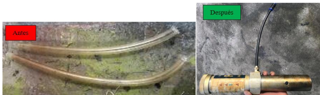
Figura 9-3. Mantenimiento de las cañerías de aire
