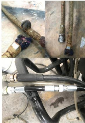
Figura 30-3. Cambio de nuevas mangueras
