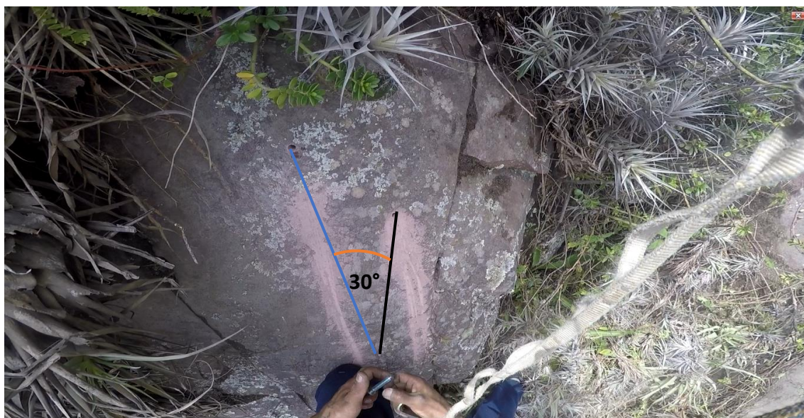
Figura 9.21. Ángulo de los agujeros para estación
