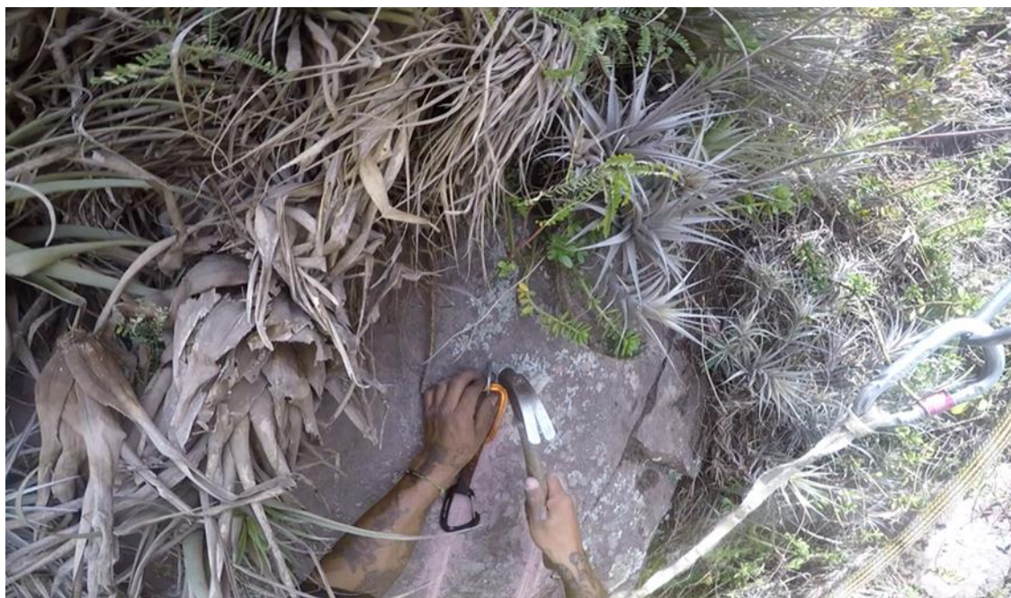
Figura 9.19. Colocación de los anclajes de estación
