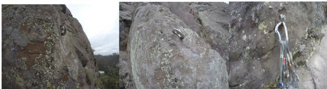
Figura 9.24. Anclajes Colocados
