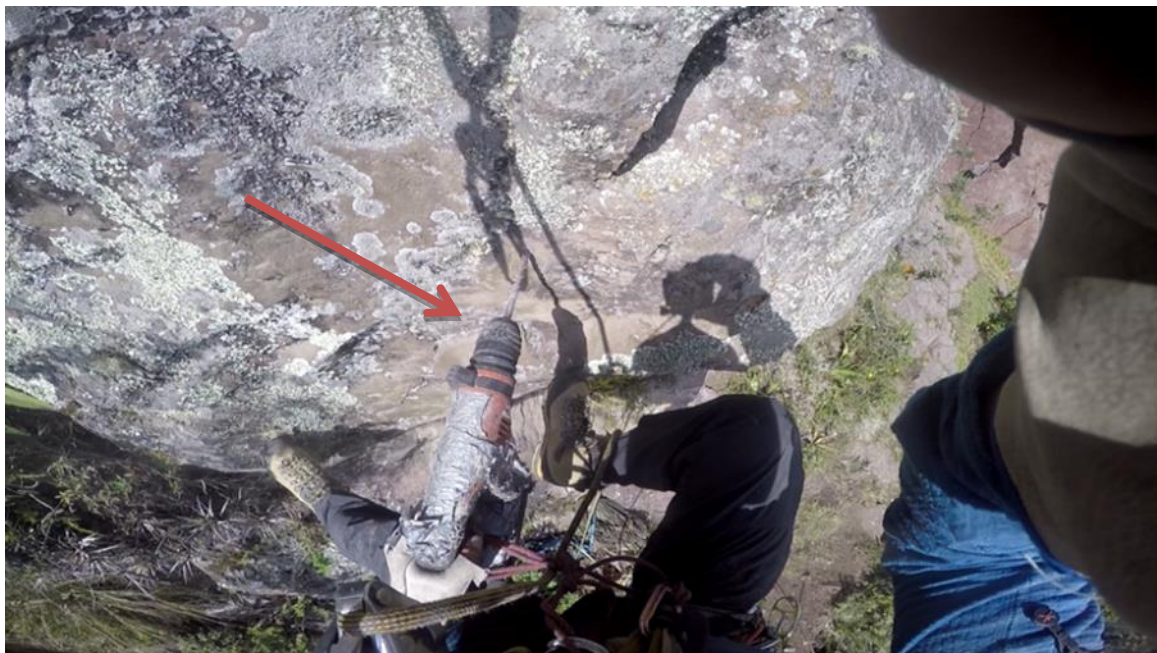
Figura 9.8. Taladro a percusión (Hilti) utilizado en la apertura de rutas
