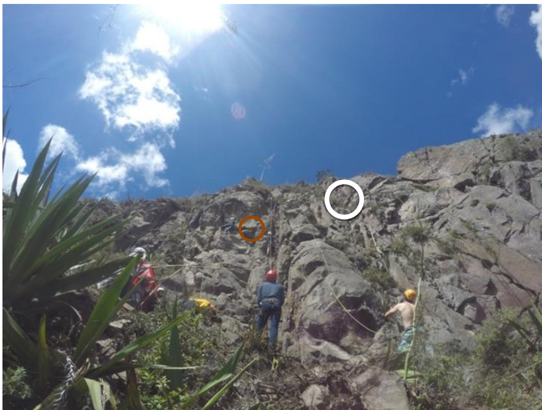
Figura 9.6. Material rocoso vulnerable a desprendimientos.
