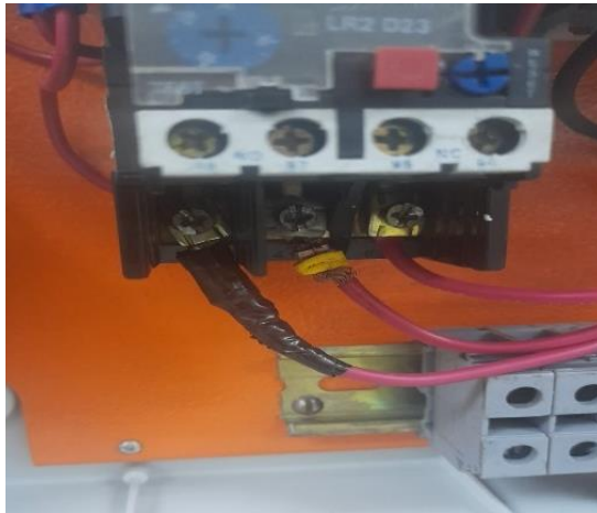
Figura 26-3: Falso contacto
