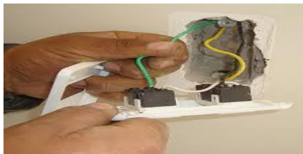
Figura 3-2: Revisión de Instalaciones
