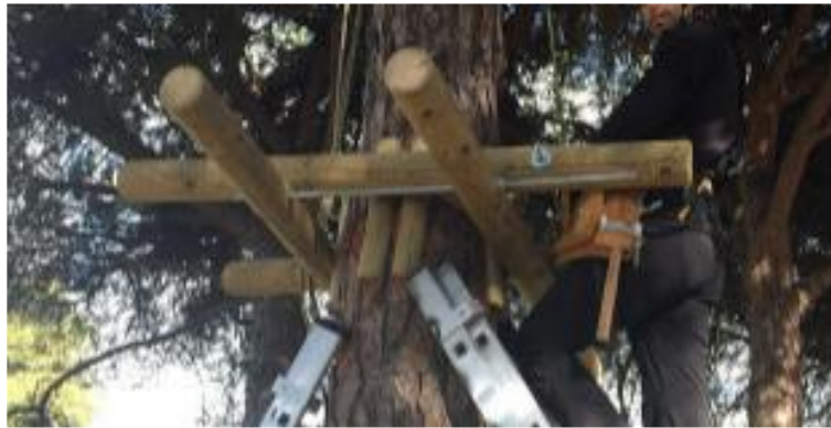
Figura 3-4. Montaje de la plataforma
