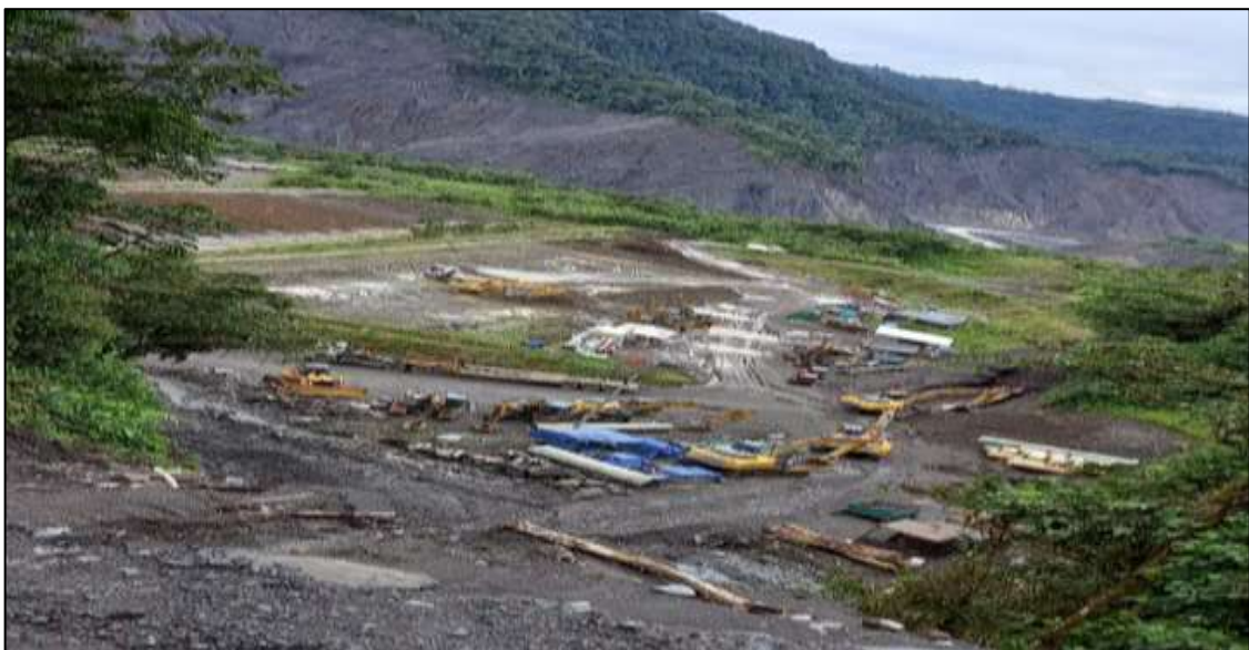
Figura 5-2: Zona de trabajo de obrador CVA, sector Piedra Fina, San Luis.
