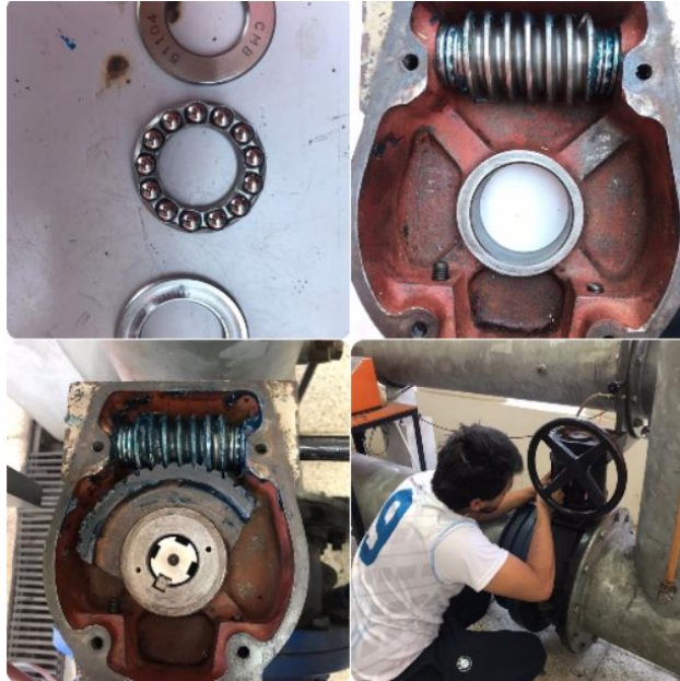
Figura 18-3: Mantenimiento de la válvula
