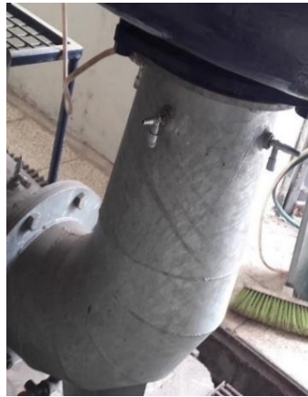
Figura 3-2: Tubo de aspiración
