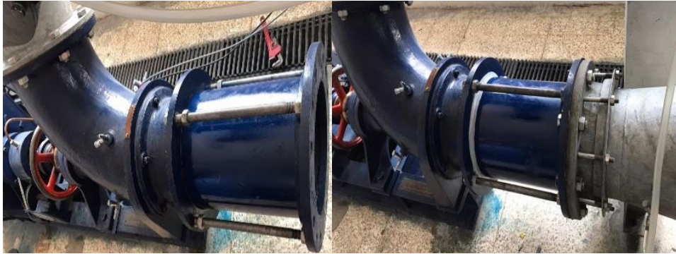
Figura 2-4: Corrección de fugas detectadas.
