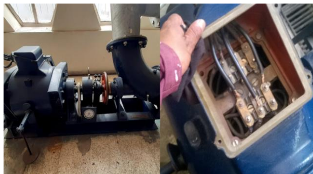
Figura 11-3: Conexión de motor-bomba
