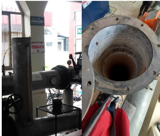
Figura 21-3: Mantenimiento del tanque
