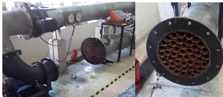
Figura 26-3: Limpieza y cambio de empaques
