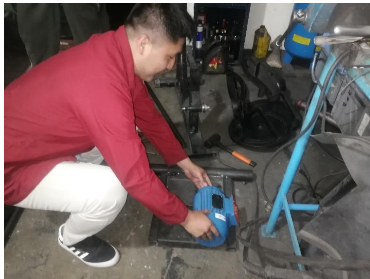
Figura 53-3: Instalación del motor en soporte
