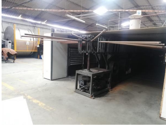
Figura 22-4: Túnel de hidrofugados sin protección
