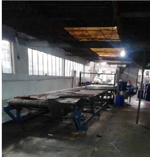
Figura 10-4: Área de impregnación
