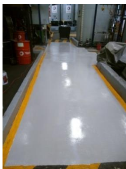
Figura 7-4: Pasillo cubierto con Resina Epóxica
