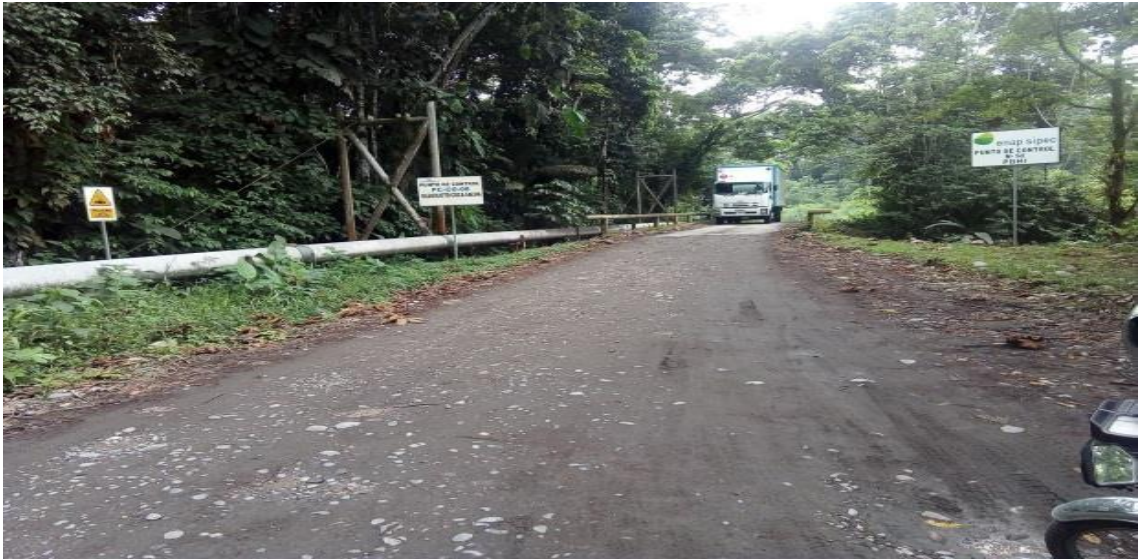
Zonas de Posibles Desastres Tubería de Poliductos petrolero al filo de las Carreteras en la Parroquia Nuevo Paraíso
