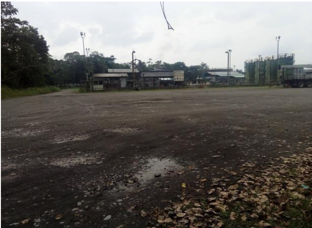
Zona de acumulación en Tanques de la extracción Petrolera para enviar por los poliductos poca precaución.
