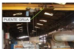
Figura N° 11.- Puente grúa de materia prima
