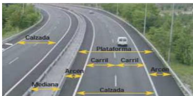
Figura 1-1: Componentes de la vía
