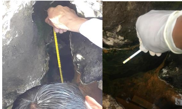
Figura 3-2. Medición de temperatura y pH
