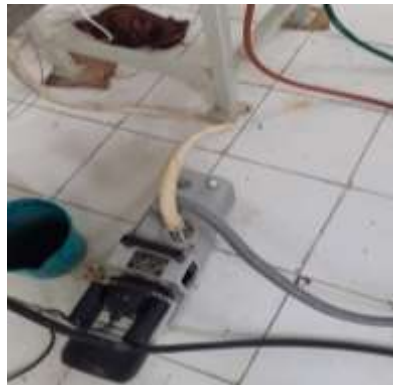
Figura 4-2: Bomba de vacío
