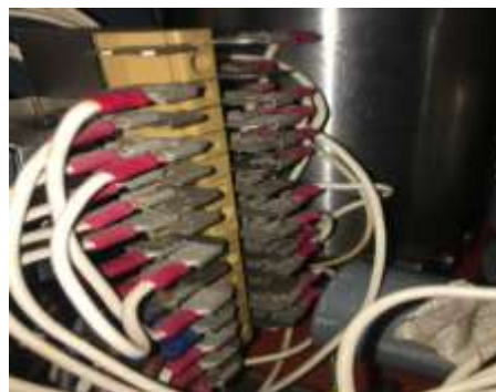
Figura 9-4. Borneras limpias y ajustadas
