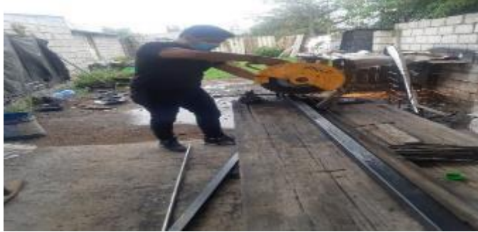
Figura 18-3: Corte de tubos cuadrados Realizado por: Moreno, G.; Pilco, V. 2022
