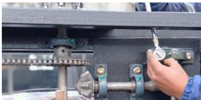
Figura 38-3: Colocación de chumacera Realizado por: Moreno, G.; Pilco, V. 2022
