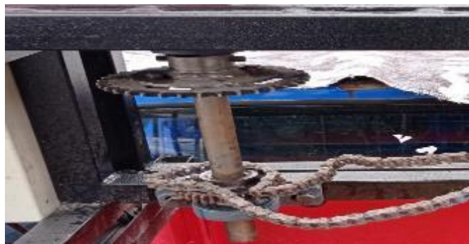
Figura 28-3: Montaje del sistema de transmisión
