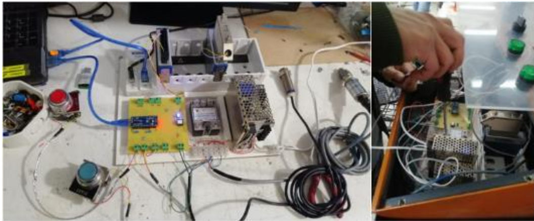
Figura 6-3: Instalación y conexión de los elementos pertenecientes al circuito de mando
