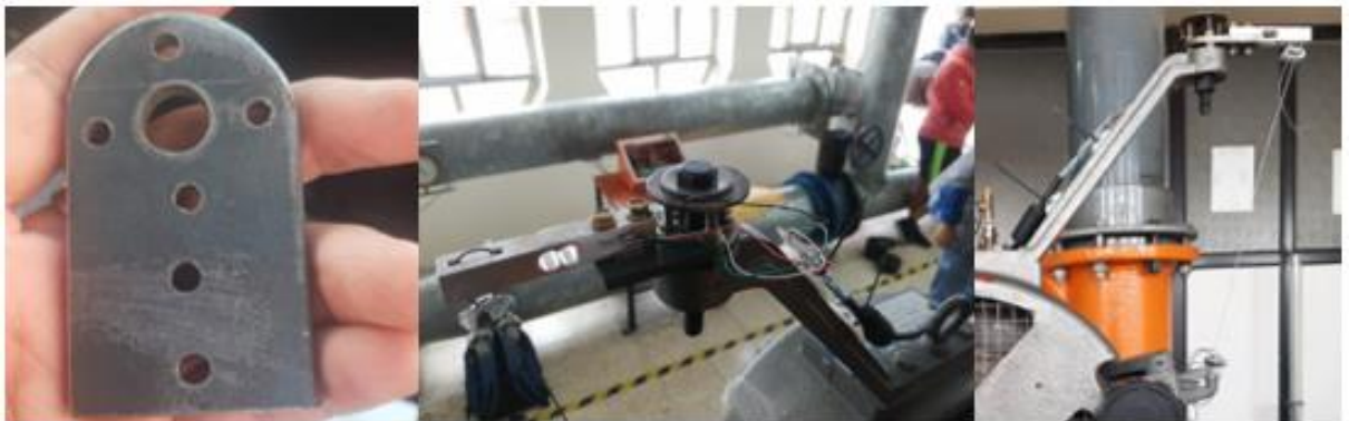
Figura 3-3: Instalación de la celda de carga
