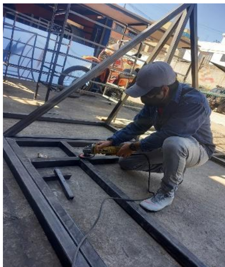
Figura 93-3: Desbaste del exceso de soldadura
