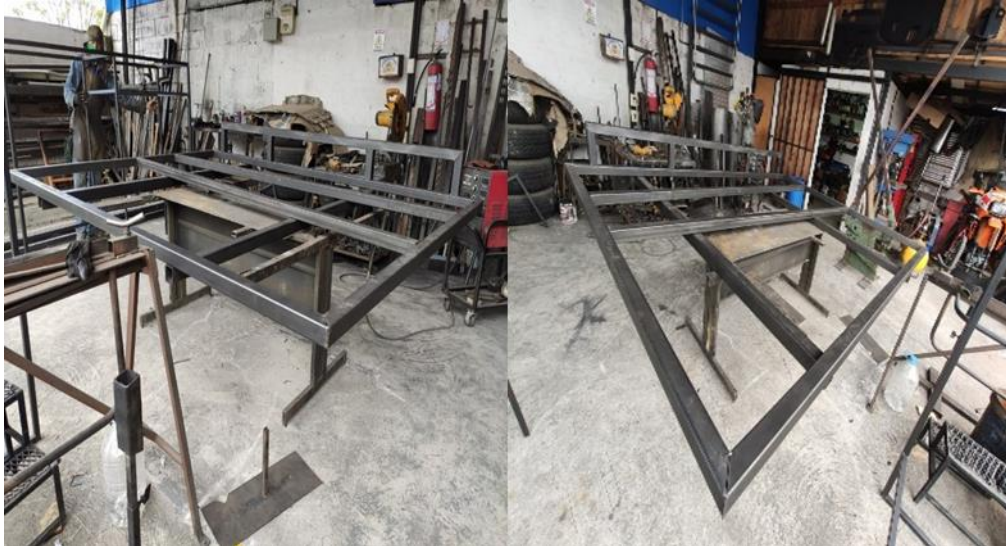
Figura 86-3: Puntos de suelda en tubos de plataforma
