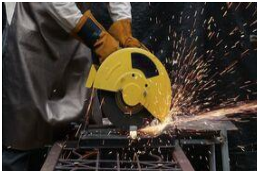
Figura 78-3: Corte de tubos con sierra eléctrica
