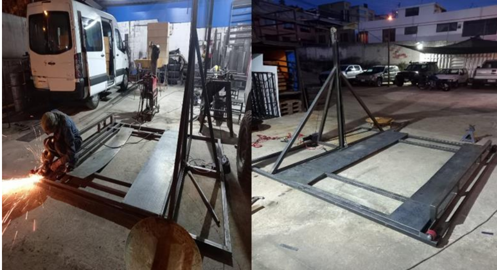
Figura 88-3: Corte y soldadura de la plancha antideslizante sobre la plataforma
