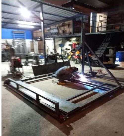
Figura 79-3: Proceso de soldadura TIG aplicado a la base
