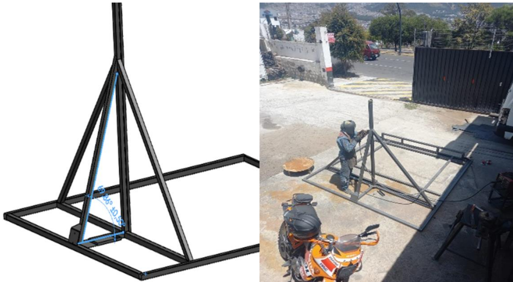
Figura 80-3: Soportes laterales y posterior de la columna
