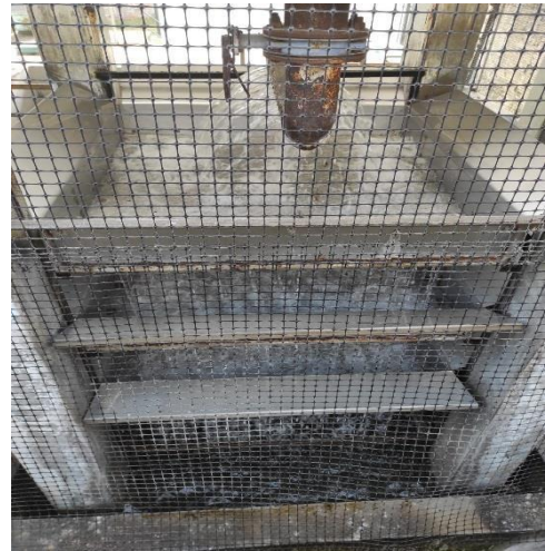
d. canaletas de aireación
