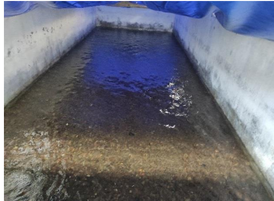
b. tanque de filtración con grava
