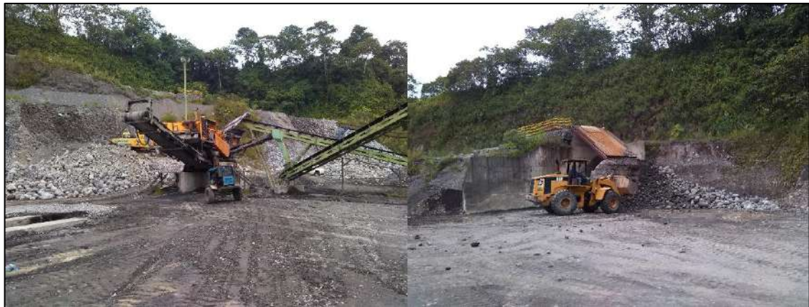
Figura 20-4: Instalaciones de la Trituradora Municipal
