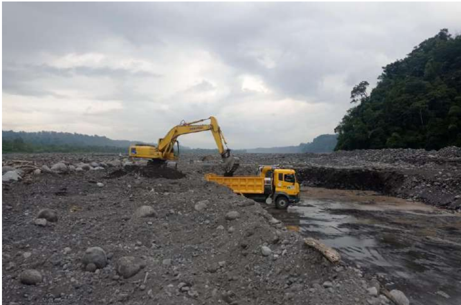
Figura 13-2: Maquinaria para el transporte de material
