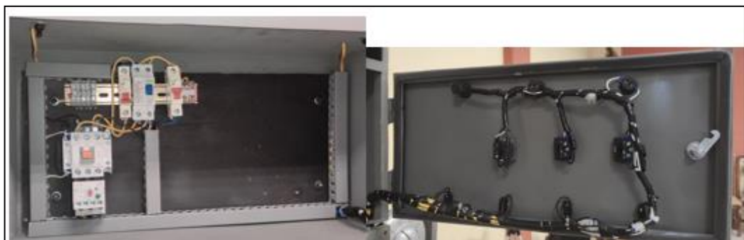
Figura 18-3: Conexión del circuito de fuerza y control
