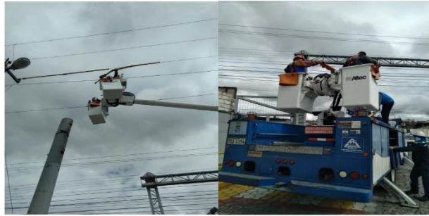
Figura 1-3: Cambio de seccionadores
