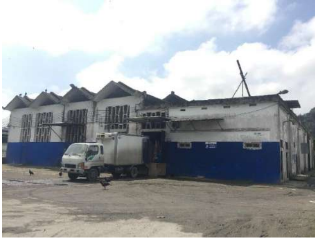
Figura 4-3: Planta de Faenamiento Realizado por: Sarabia C. 2022
