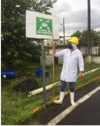
Verificación de la altura de instalación
