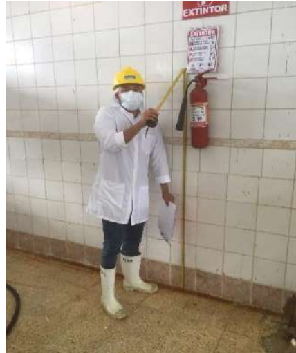
Altura de instalación del extintor
