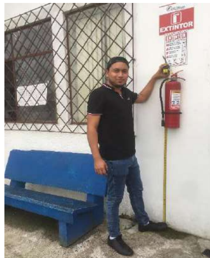
Altura de instalación del extintor
