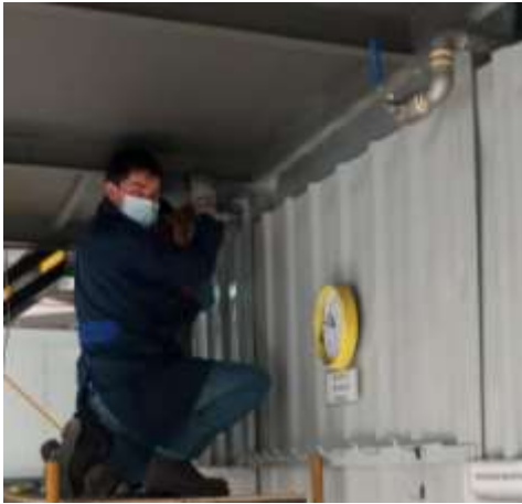
Figura 37-4: Colocación de válvula de globo.
