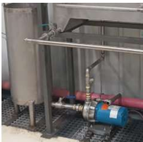
Figura 42-4: Colocación de la bomba centrífuga
