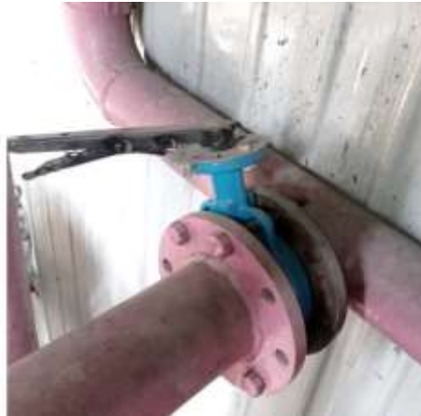
Figura 7-4: Posición válvula mariposa
