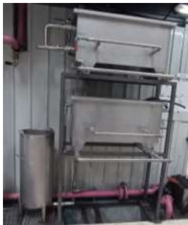
Figura 41-4: Colocación del tanque de desfogue
