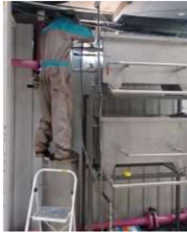
Figura 43-4: Colocación de la tubería de retorno
