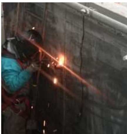
Figura 36-4: Colocación de neplos corridos
