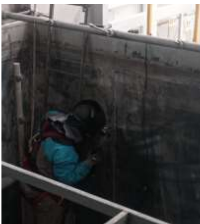
Figura 35-4: Perforación de la cuba
