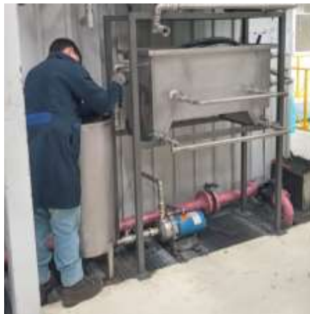
Figura 40-4: Colocación de válvula de globo
