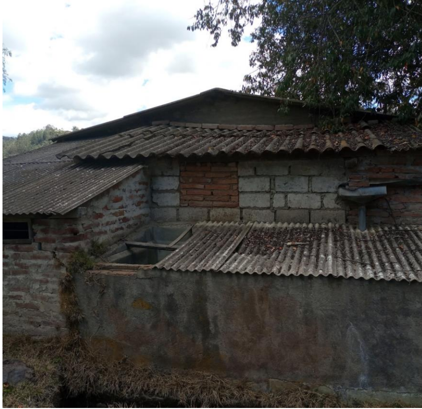
Figura 13-4. Cuarto de bodega
