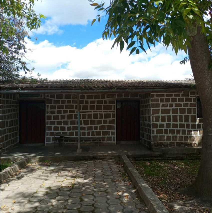
Figura 6-4. Parte frontal del centro Realizado por: Villalobos, R, 2022
