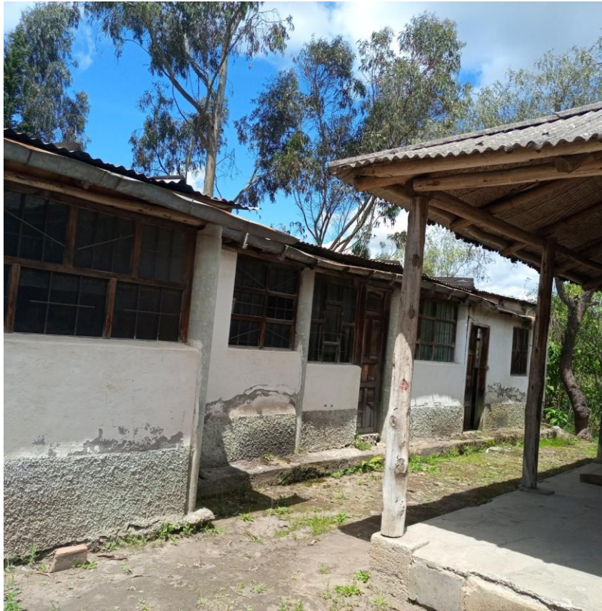
Figura 10-4. Bodegas e instalaciones del centro
