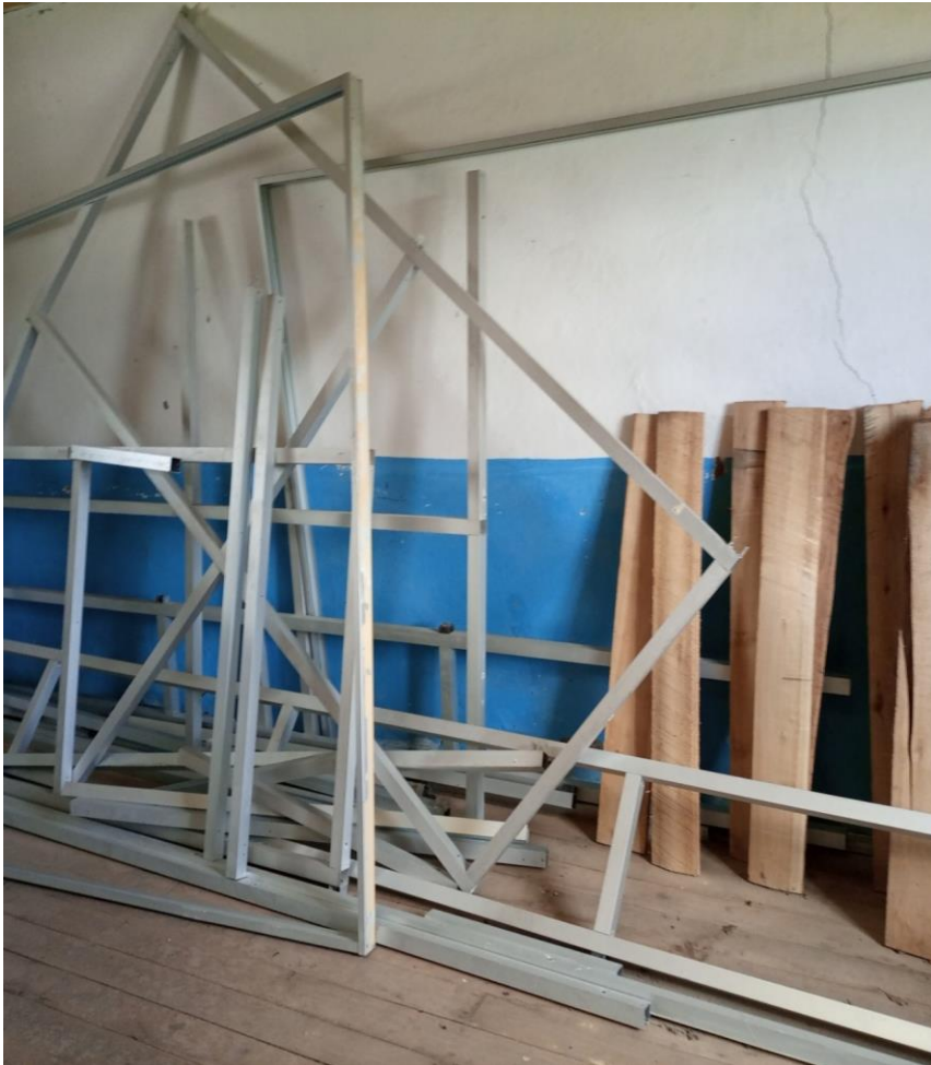
Figura 7-4. Parte interna del centro Realizado por: Villalobos, R, 2022
