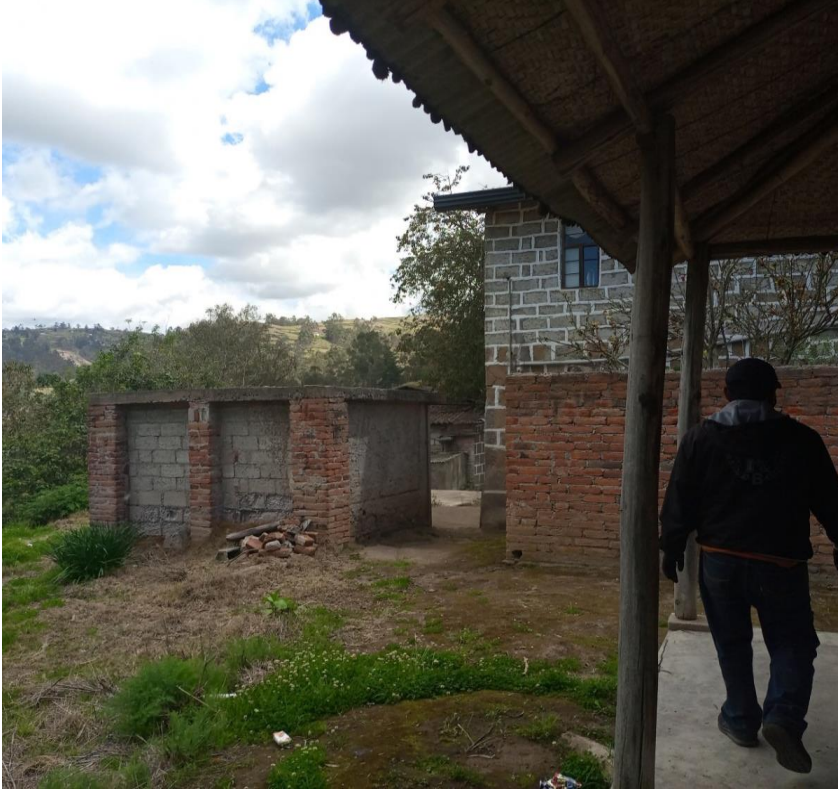
Figura 12-4. Baños e instalaciones
