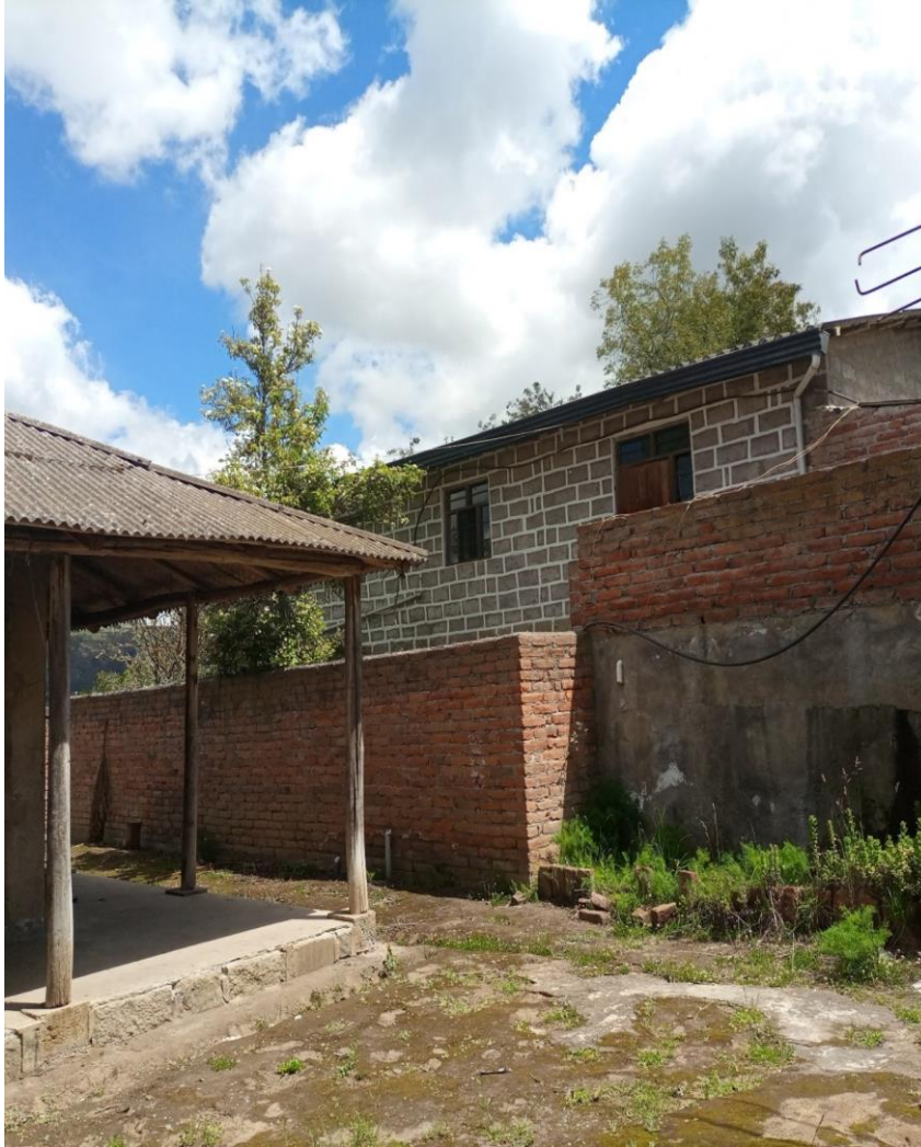
Figura 9-4. Patio posterior a la cocina del centro
