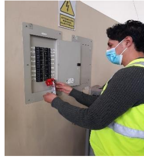
Ilustración 17-4: Dispositivo de bloqueo para interruptores
