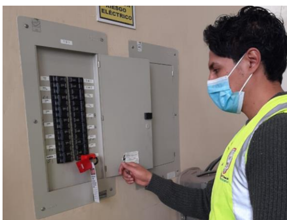
Ilustración 6-4: Implementación de dispositivos LOTO 1. Fuente: Toapanta, Paúl. 2022
