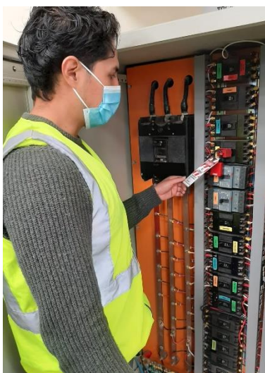
Ilustración 9-4: Implementación de dispositivos LOTO 4.
