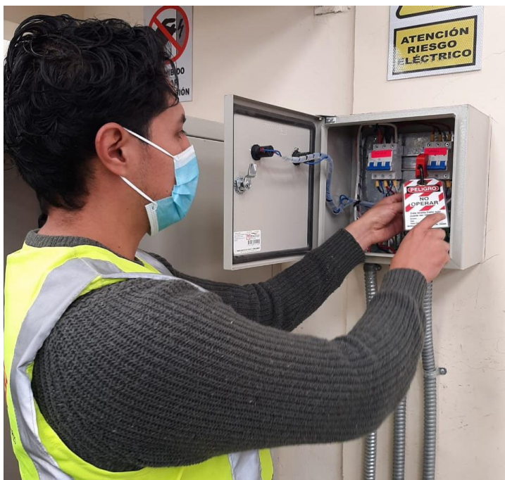
Ilustración 7-4: Implementación de dispositivos LOTO 2.
