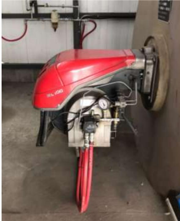
**Ilustración 6-3:** Quemador actual marca RIELLO RL-100.
