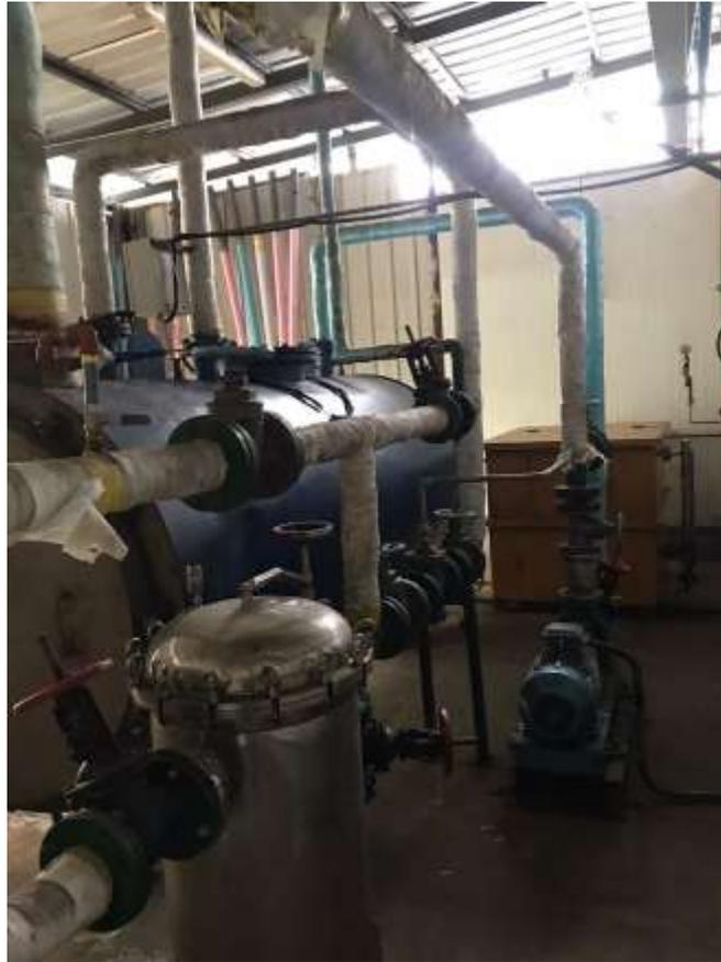
**Ilustración 9-3: Tuberías de succión y retorno.**
